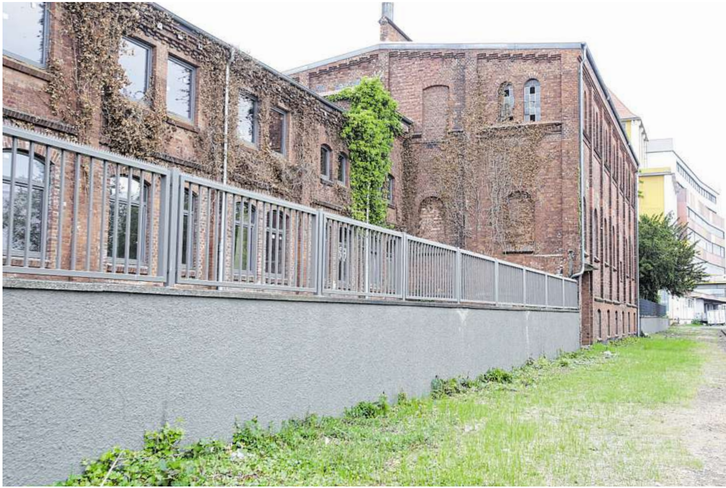
Der Verein Zentrum für Kollektivkultur möchte drei Backsteingebäude an der Cuxhavener Straße als Kulturzentrum nutzen. FOTO: ROLAND SCHEITZ
