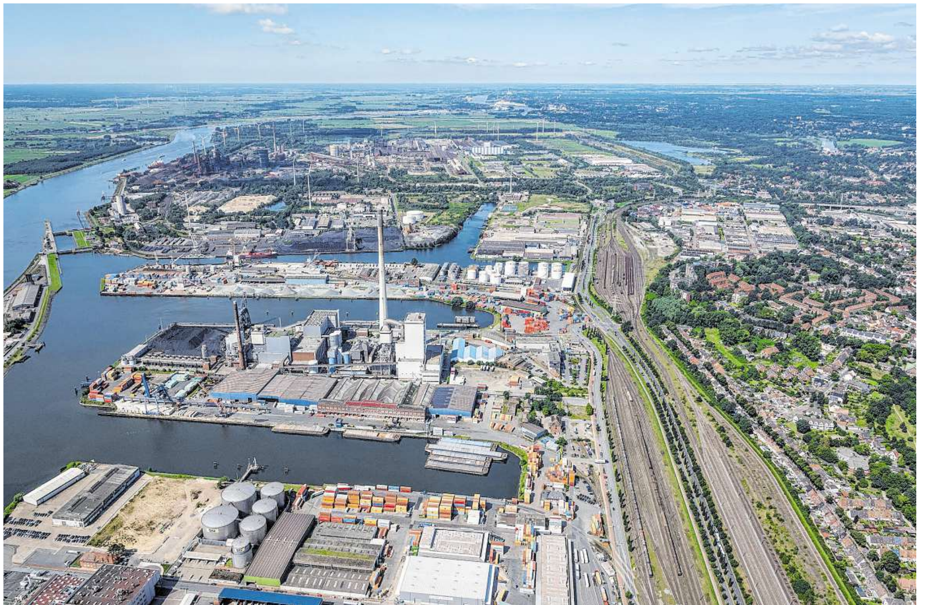
Im Kalihafen (Vordergrund) soll eine neue Schwerlastkaje gebaut und die Hafensohle vertieft werden.
